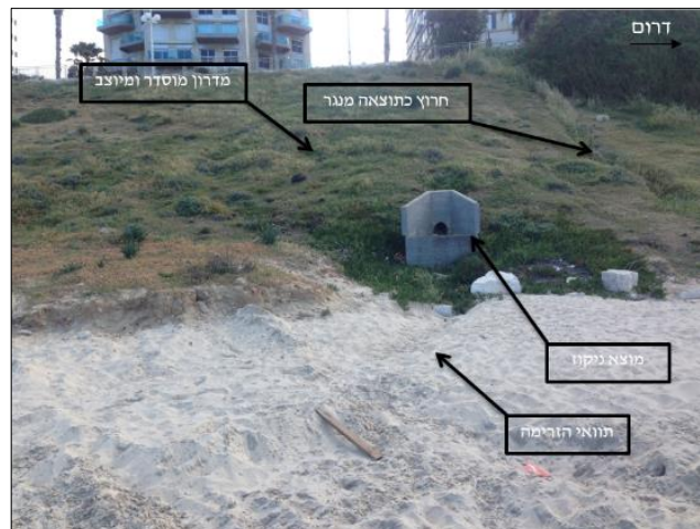
תמונה 2.2.4-4 : מוצא ניקוז מכיוון הטיילת (מבט לכיוון מזרח)
