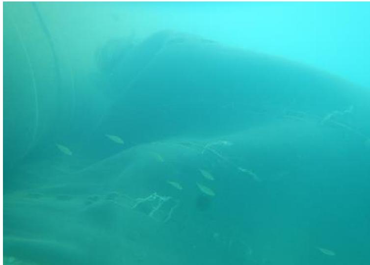
תמונה 9: מערום אריג מיריעת הרצפה שנסחף בסערה. אריג זה היה ללא גיאומטריה עליו בתחילת הסערה. האריג נמצא בצידו המזרחי של הגיאומטריה הצפון מזרחי לפי התקדמות ההנחה ביום הניטור ה-2.
