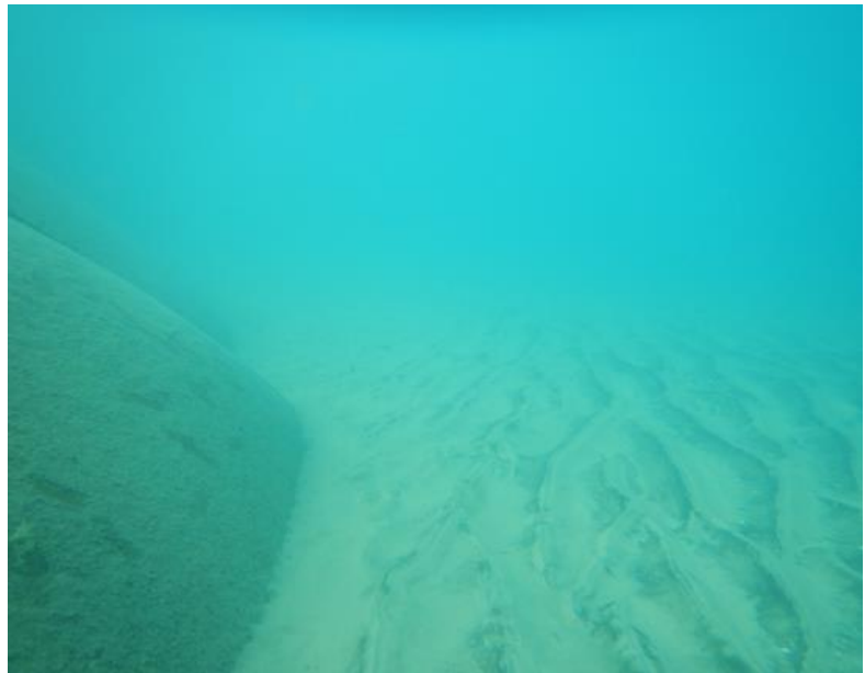
תמונה 6: מערום החול בצידם המערבי של הגיאוטיובים. הערמות החול מגיעה עד כמעט מחצי גובהו של הגיאוטיוב.
