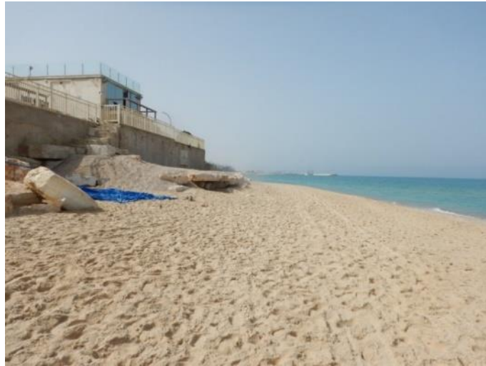
תמונה 14: טרסת ההגנה על מסעדת החוף. החול נערם עד לשורת האבנים השנייה מלמעלה
