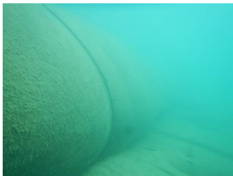
תמונה 7: צדו המזרחי של הגיאוטיוב. תעלת המיחתור בבסיס הגיאוטיוב שנצפתה בניטורים הקודמים לא קיימת ביום הסריקה של ניטור שלישי
