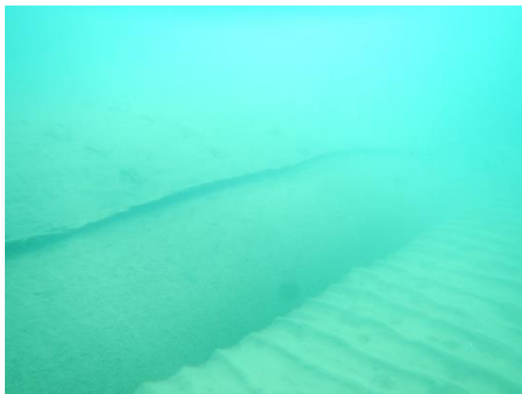
תמונה 6: צדו המערבי של הגיאוטיוב , החול נערם עד ליותר ממחצית גובה הגיאוטיוב
