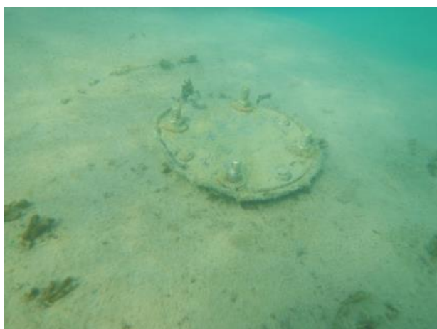
תמונה 5: הגיאוטיוב ומכסה המילוי. הגיאוטיובים נצפו בניטור זה כנקיים מאצות
