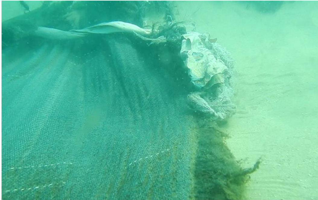
תמונה 9: קצוות פרומים, אזורים "חדשים" שהתגלו עם חלקי יריעות וקצוות פרומים
