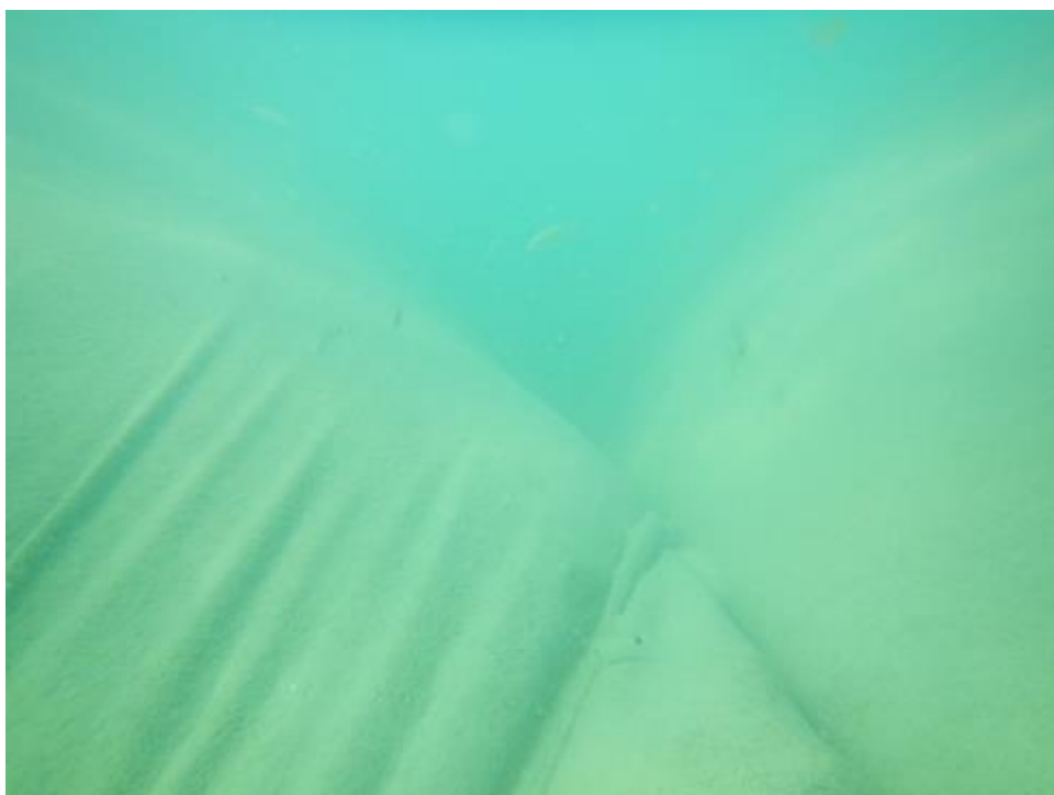
תמונה 6: גיאומטריות, יריעות "נקיות" מכיסוי חי/אצות
