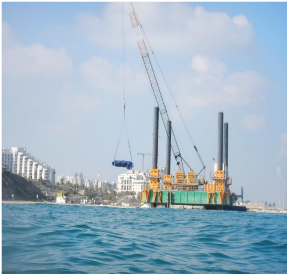
תמונה 1: אסדת העבודה במיקומה להנחת מערך הגיאומיוב
