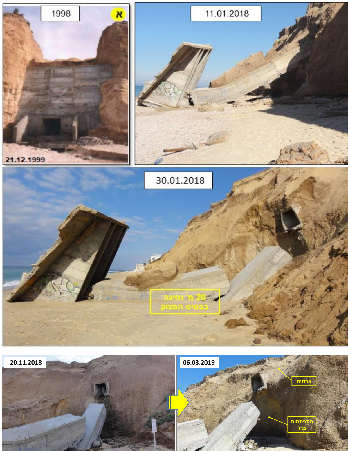
איור 3.3.3. נסיגת בסיס המצוק במעביר המים בשנים 1998–2018. קריסת מעביר המים והתפתחות צנור במוצא שפך תעלת הניקוז.
