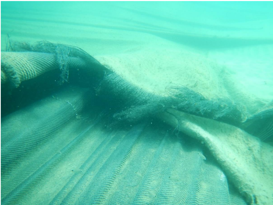
תמונה 11 : יריעות של גיאוטיוב שהתפרקו בסערות החורף, ריף שלישי מדרום
