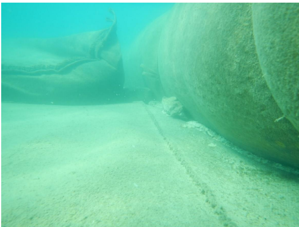
תמונה 8 : גיאוטיוב בריף השני מדרום. גיאוטיוב תקין מימין ולידו גיאוטיוב נמוך (איבד חלק מהחול)
