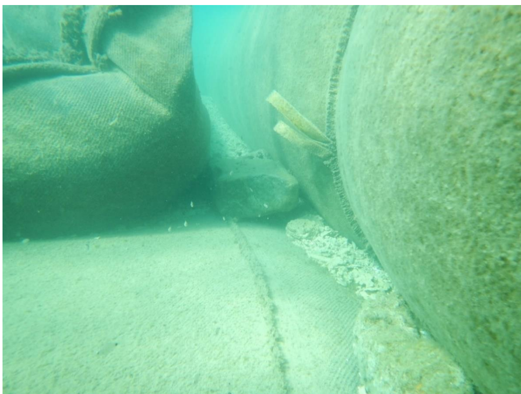
תמונה 9: גיאוטיובים בריף השלישי מדרום. גיאוטיוב תקין מימין וגיאוטיוב נמוך (איבד חלק מהחול) משמאל. הצטברות אבנים מגדלים שונים בסמוך לבסיס הגיאוטיוב.
