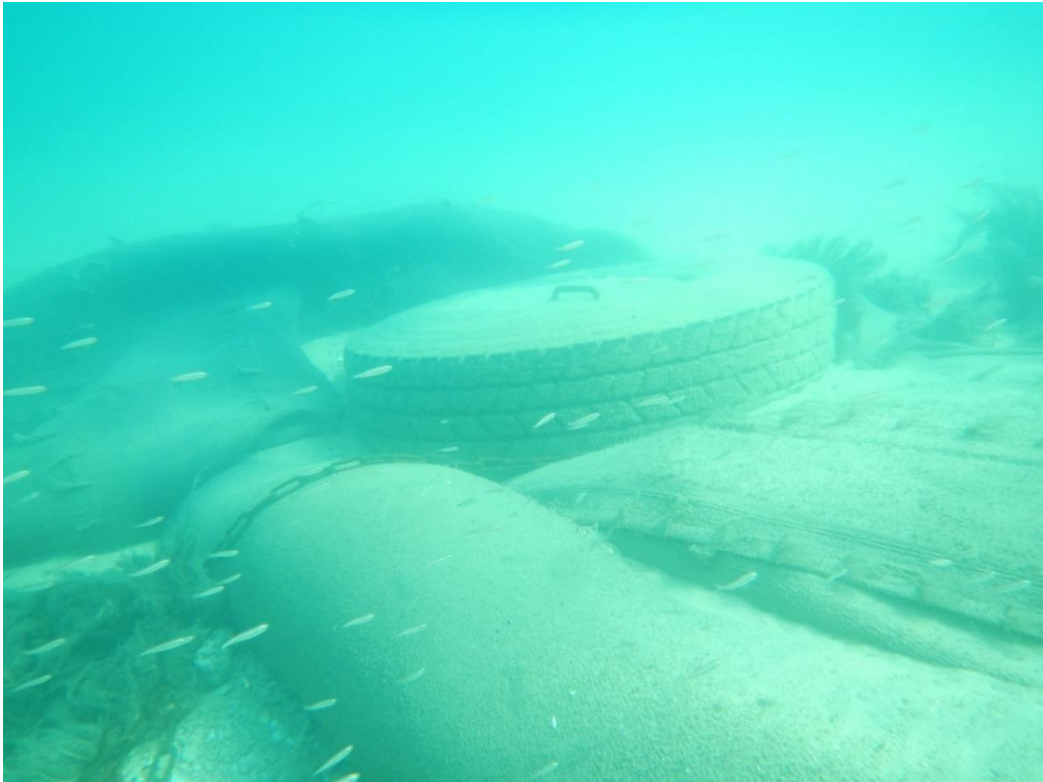
תמונה 10: שרידי גיאוטיוב, שטיח קרוע ומתקני עגינה
