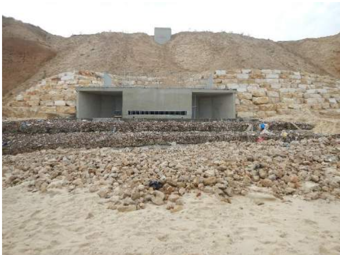
תמונה 14: מוצא מובל המים מגג המצוק. תמונה ימנית מלפני סתיו 2019. תמונה שמאלית המוצא החדש.
