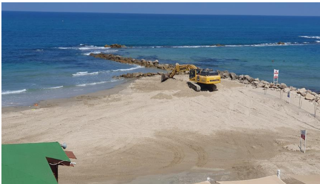
איור 3.2 : אזור החוף היבש מדרום ללגונה בחוף "הסלע" בת ים. עבודות פיזור חול ההזנה.
