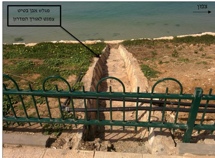
תמונה 2-1.7 : צפון המקטע-מגלש אבנים בטיט צמנט לאורך המדרון (מבט מכיוון מזרח למערב)
