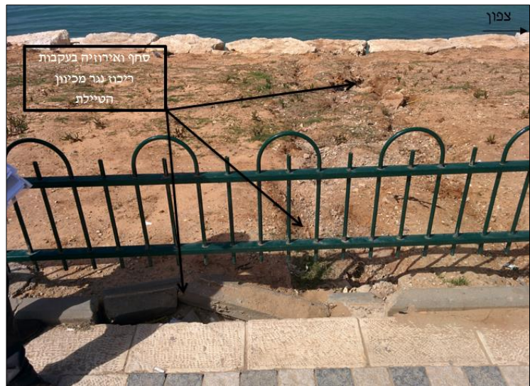
תמונה 3-1.7 : צפון המקטע-מגלש אבנים בטיט צמנט לאורך המדרון (מבט מכיוון מזרח למערב)
